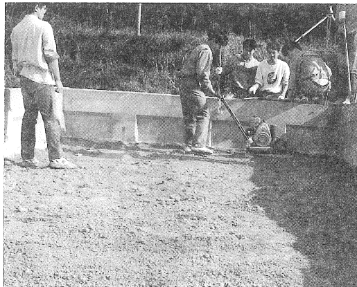
写真-6 盛土状況
