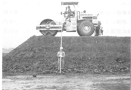
写真-4 盛立て状況
