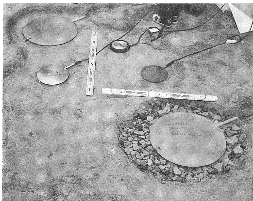
写真-5 土圧計設置
