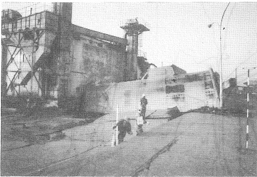
写真3 背後地盤に築造された構造物の被害(秋田港)
