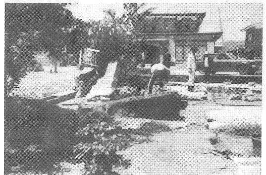
写真6 液状化により噴出した泥水と家屋の被害
