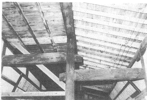
写真-7 興禅寺本堂・入側柱上部繫梁
