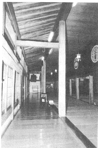
写真-8 保善院本堂・入側柱と繫梁
