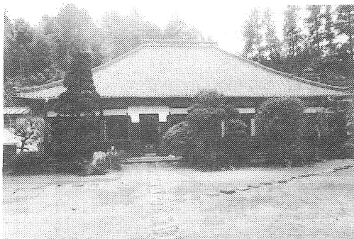
写真-6 興禅寺本堂・全景
