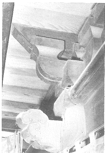
写真16 内陣正面丸柱上部及び斗拱見返り (板決り、台輪切口跡)
