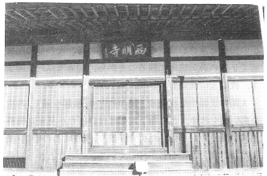
写真6 本堂正面入口
