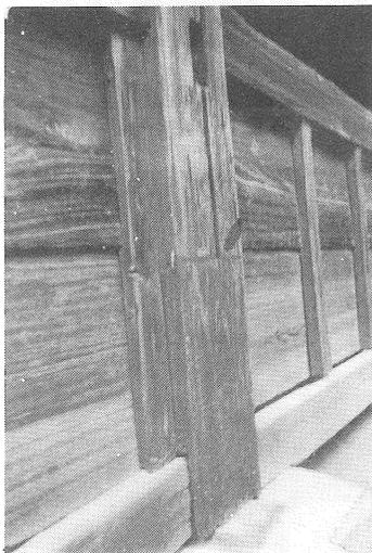
写真4 側柱の根継ぎ
