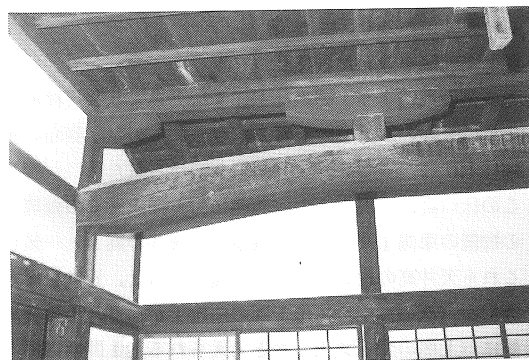
写真19 次の間西側面上部大梁
