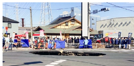
図－3 埼玉県八潮市の道路陥没状況 3)
