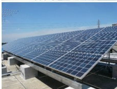
太陽光発電装置(10kW, 10kW)
