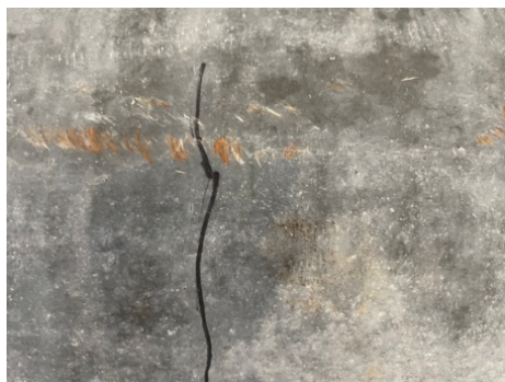
図2 横ひびの様子 (2m 柱)
