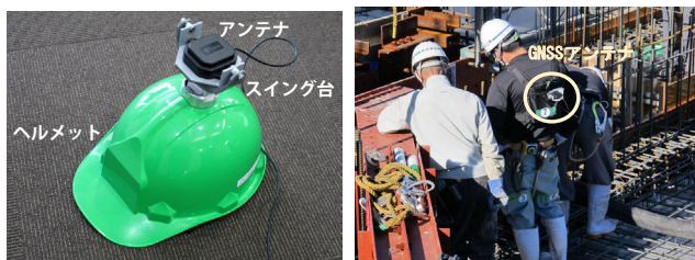
写真1 GNSS アンテナの装着状況の例
