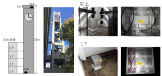
図2 地震計設置概要図および設置写真
