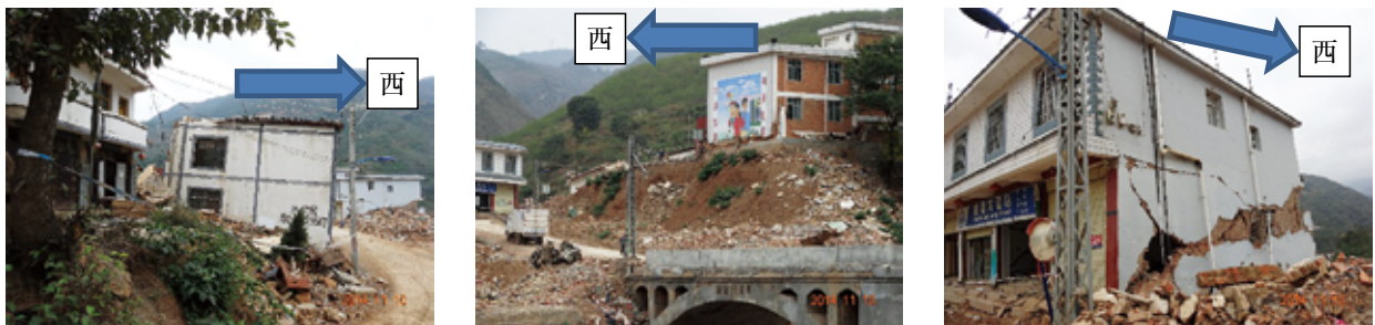
写真4 建物短辺側の被害（左：建物4；中：建物5；右：建物6）
