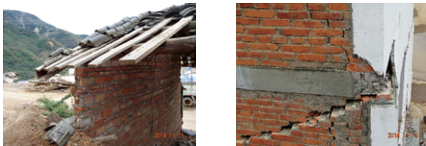
写真6 建設工法（左：建物8、右：建物9）
