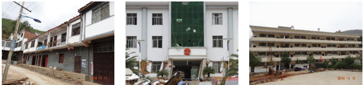
写真3 建物長辺側の被害（左：建物1；中：建物2；右：建物3）
