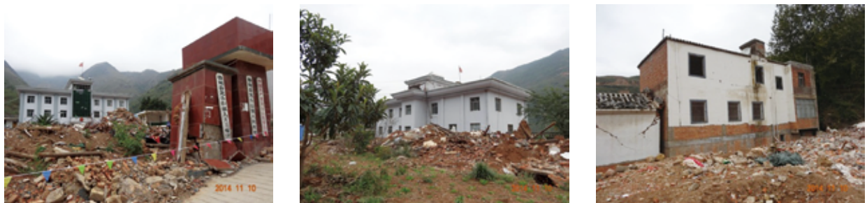
写真5 屋上の小屋の被害（左：建物2の正面；中：建物2の裏面；右：建物7の裏面）
