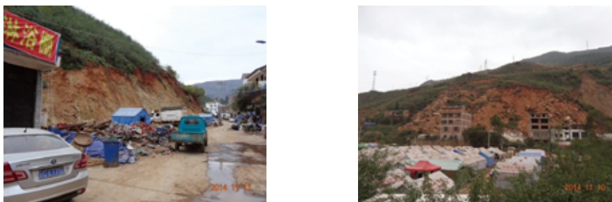
写真2 崖崩れ（左は写真1のA、右は写真1のB）
