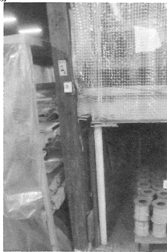
写真 18 材料置場と柱の取り付け
