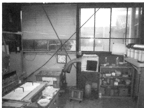
写真1 C棟南面中央部のブレース切断
