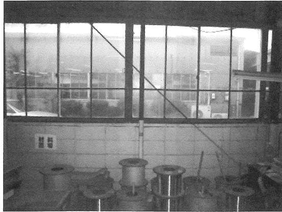
写真4 C棟窓ガラス
