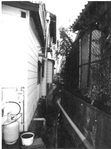
写真 25 敷地南側の境界
