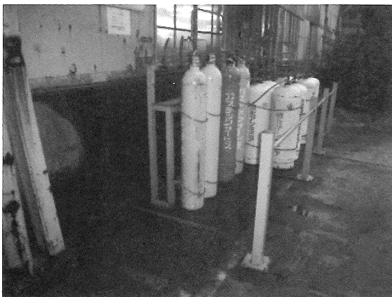
写真 21 C棟南側のガスボンベ置場
