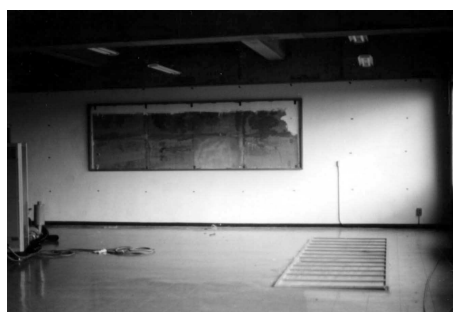
2階教室間仕切壁 (A室-B室)
