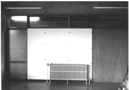
2階教室-廊下間仕切壁
