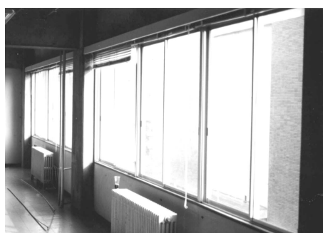
2階教室開口 (外壁)
