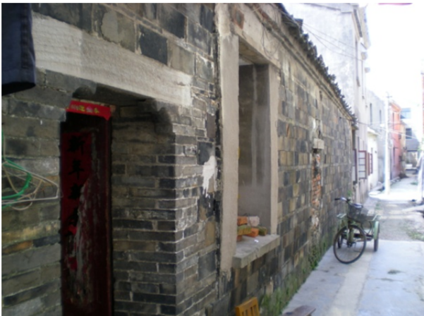
写真2:淳化街道咸墅村の民家
